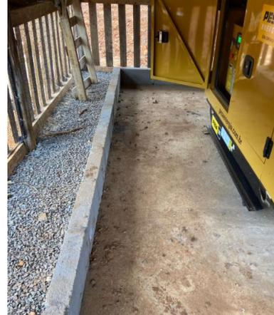
Figura 2 - Bacia de contenção na área do gerador
