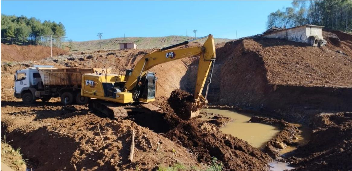
Figura 5 - Vista para abertura das valas prevista para passagem da água.
