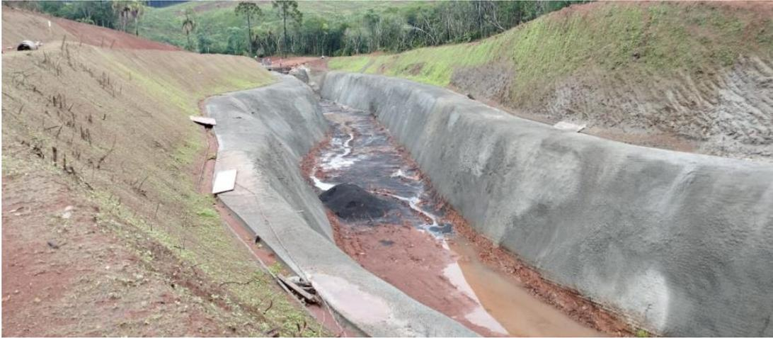
Estabilização do canal de adução e implantação de hidrosemeadura nas laterais do canal como forma de proteger de erosões.
