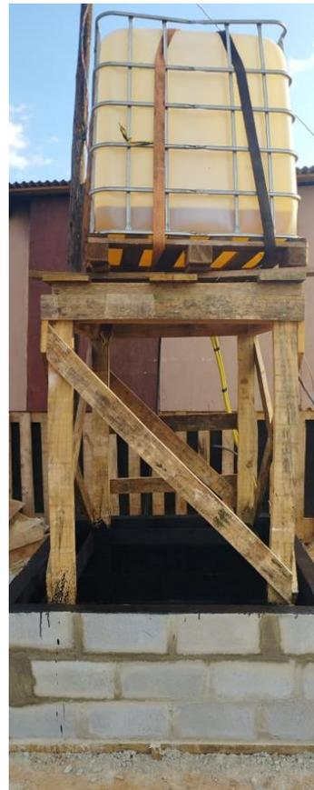
Bacia de contenção do IBC que armazena combustível usado no gerador
