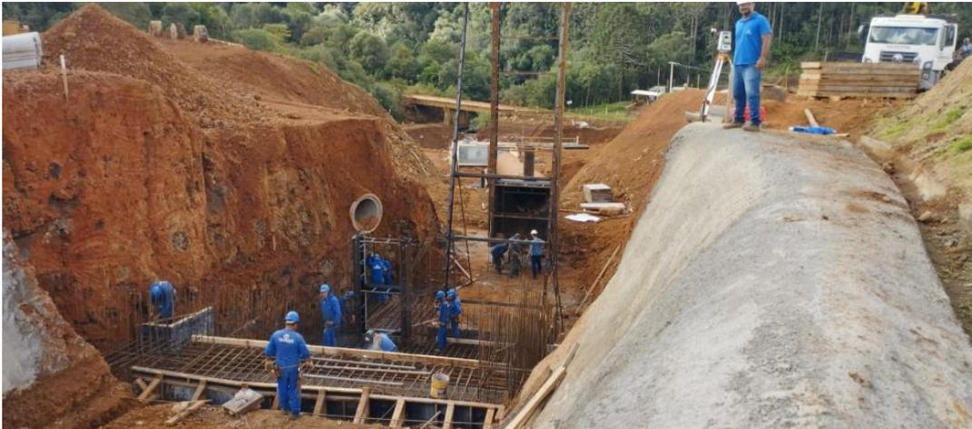
Final do canal de adução, início da construção da camera de carga.
